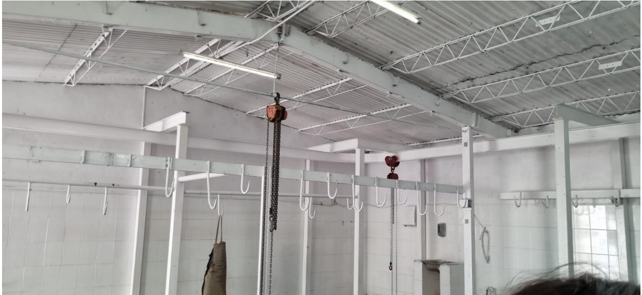
Ilustración 5. 3 Instalación y adaptación del equipo Fuente: Elaboración propia 2024
